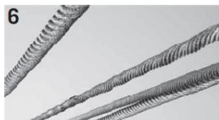
6 Ocelová lana se formují do tvaru vrtáku, protože ocelové lano dřelo o části konstrukce nebo se vleklo skrze příliš úzké drážky.
