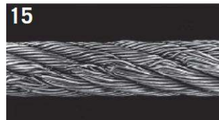
15 Toto lano bylo taženo přes okraj kladkostroje. Všimněte si stopy poškození.
