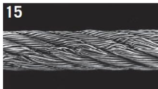
Toto lano bylo taženo přes okraj kladkostroje. Všimněte si stopy poškození.
